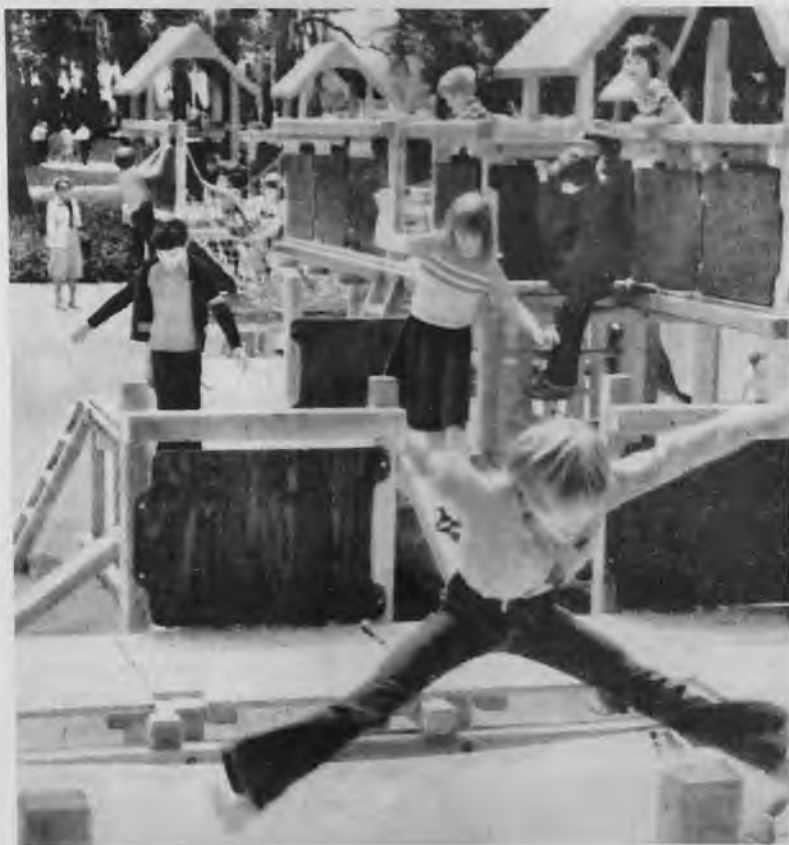
Рис. 16. Модульная сетка из деревянного бруса облегчает устройство платформ
